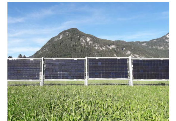
Solarzaun in Beton, Punktfundament
