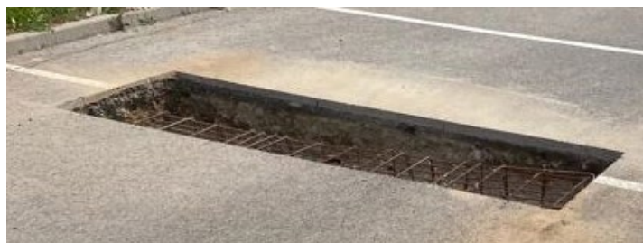
Semelle renforcée (+ ancrages)
